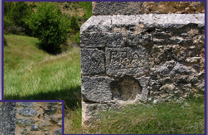
Detalle de los sillares cuadrangulares del plinto donde se asienta en su parte más baja la estructura del arco.
