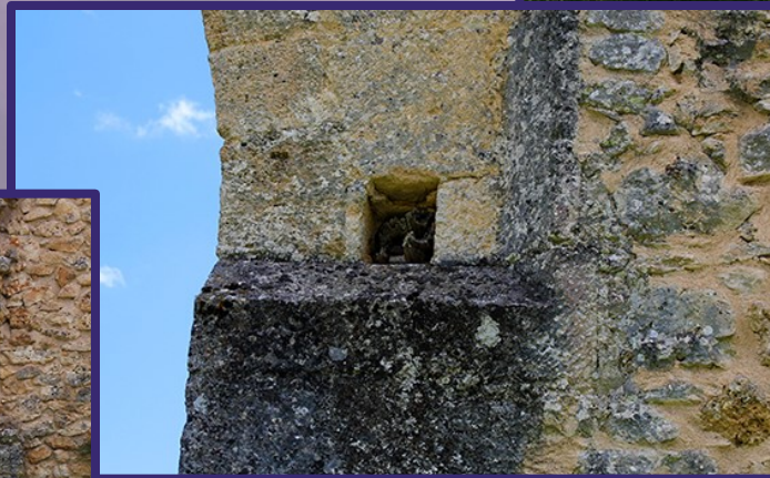
En la construcción pueden observarse todavía varios "mechinales" u orificios en la piedra supuestamente encargados de sustentar vigas de madera o andamiaje de la construcción. Algunos de ellos conservan la madera original en su parte interna.
